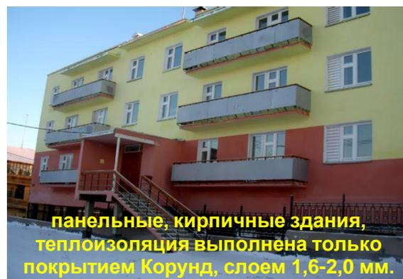
**панельные, кирпичные здания, теплоизоляция выполнена только покрытием Корунд, слоем 1,6-2,0 мм.**
