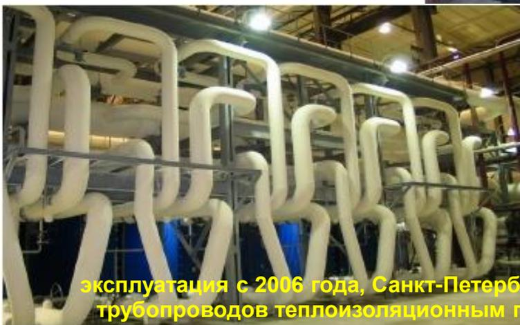
эксплуатация с 2006 года, Санкт-Петербург, теплоизоляция трубопроводов теплоизоляционным покрытием Корунд
